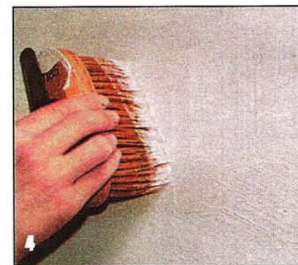
Дав отстояться смеси не менее 30 мин, её снова перемешивают. Затем с помощью щётки (или валика) на стену наносят первый слой штукатурки.
