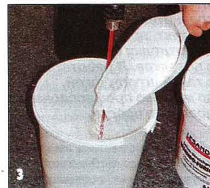
Глиняную штукатурку постепенно засыпают в воду, постоянно перемешивая. Полученный раствор перемешивают до тех пор, пока не исчезнут комочки и не образуется однородная смесь.
