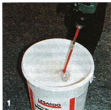
Даже если глиняную штукатурку используют как первичное покрытие без добавления пигментов, её тщательно перемешивают в сухом виде.
